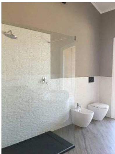
Figura 1 piatto doccia marmoresina ardesia e sanitari Connect Ideal Standard filo muro senza brida
